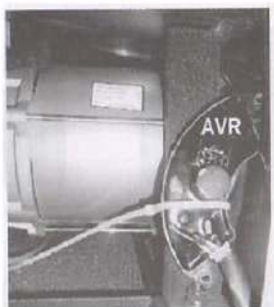
Figura B – Căutați locația AVR (regulator automat de tensiune). Este posibil ca acest element să trebuiască să fie schimbat când se uzează excesiv.
